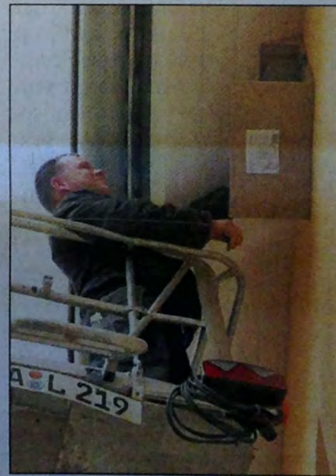
Kotbrett schützt Fassade: Dachdecker-Geselle Ronny Hanspach montiert ein Doppelnest für Mehlschwalben.
